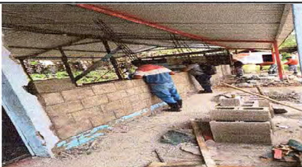
Foto 3: COLOCACION DE BLOCKS,
