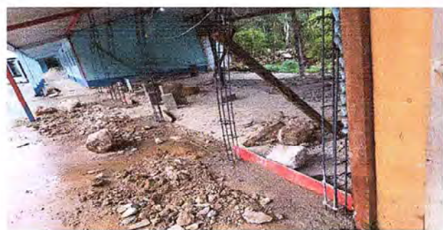
Foto1: INICIO DE TRABAJO, REHABILITACION DEL MUDULO 2.
