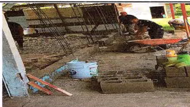
Foto 2: COLOCACION DEL CIMIENTO DEL MODULO 2.
