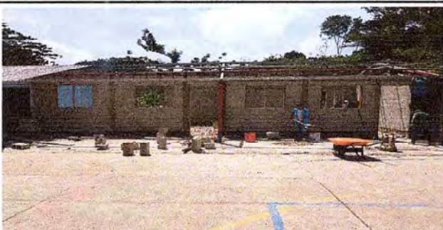
Foto 5: INSTALACION DE TECHOS DE LAS DOS AULAS.
