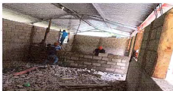
Foto 4: COLOCACION DE LA DIVISION DE LAS DOS AULAS.
